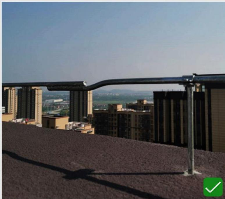
1. 接闪带安装平正顺直，使用成品支撑件固定，固定点高度不小于150mm。
