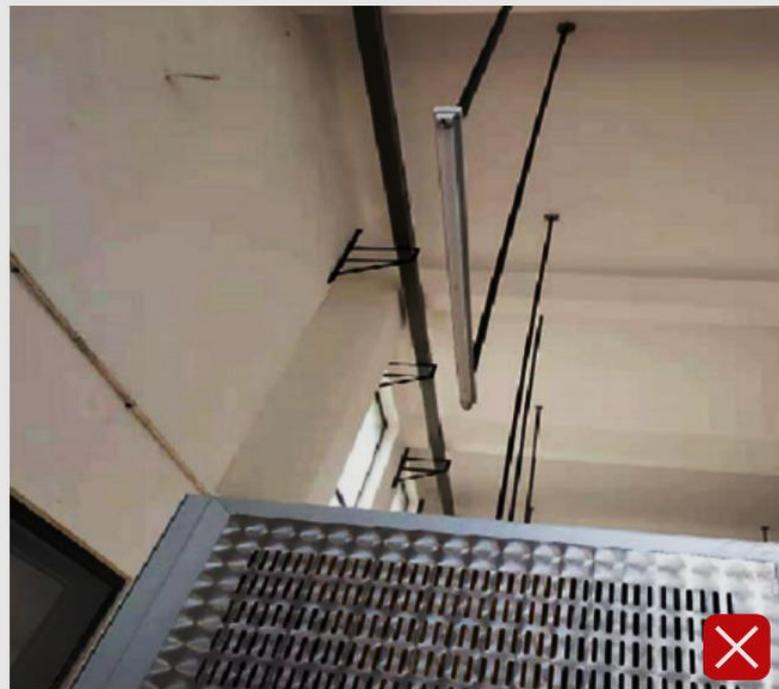
配电房内灯具安装在配电柜、变压器正上方，影响照明效果，且不利于灯具维修。
