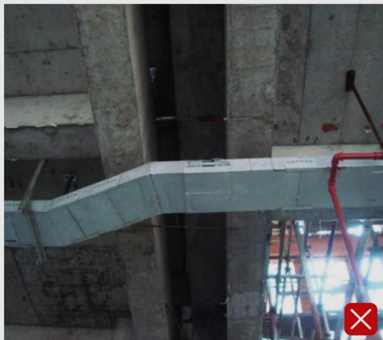
1. 建筑物变形缝处，桥架未设置变形补偿装置。
