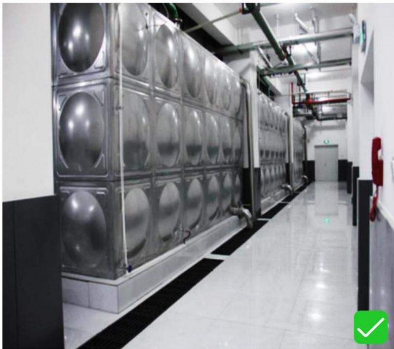
1. 水箱（池）的溢流管与水箱排空管分开设置。
