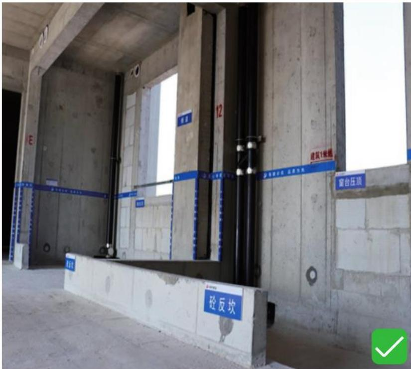
1. 支模前对接触面结构凿毛处理, 清理干净。
