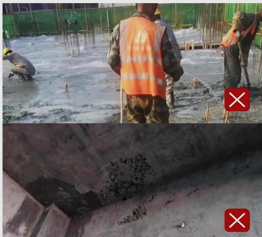
墙柱混凝土分层浇筑，分层高度不大于2.0m，振捣均匀、密实。
