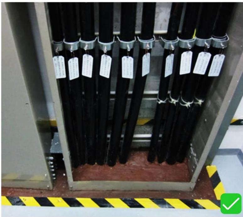
桥架穿墙或楼板处使用防火材料封堵密实。
