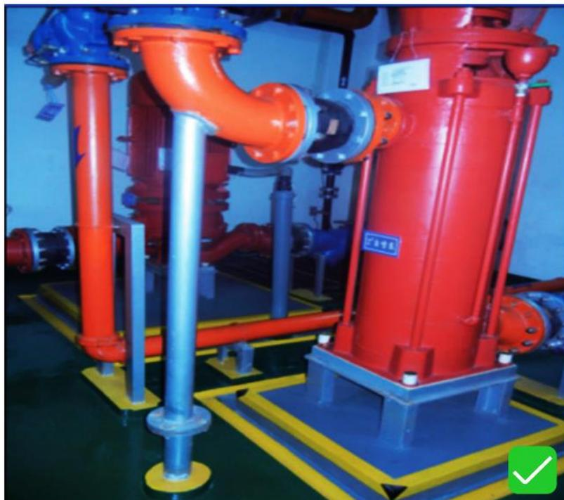
1. 水泵纵向中心轴线与基础中心线重合对齐，安装平整周正，固定牢靠。
