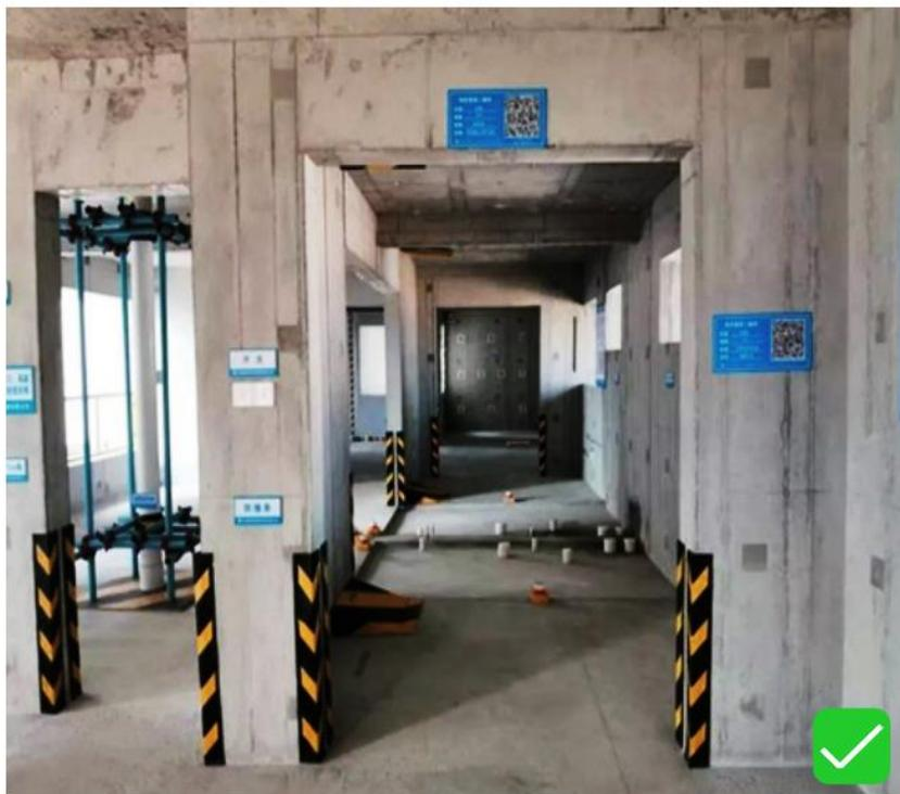
混凝土墙柱阳角部位、楼梯踏步用防护措施进行保护。
