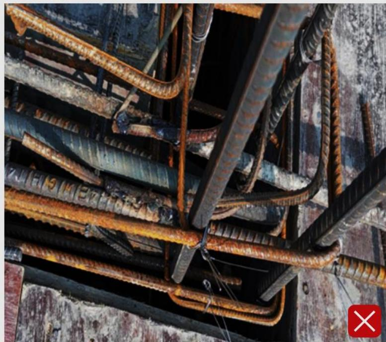
跨接钢筋使用螺纹钢，焊缝不饱满，夹渣，咬边。
