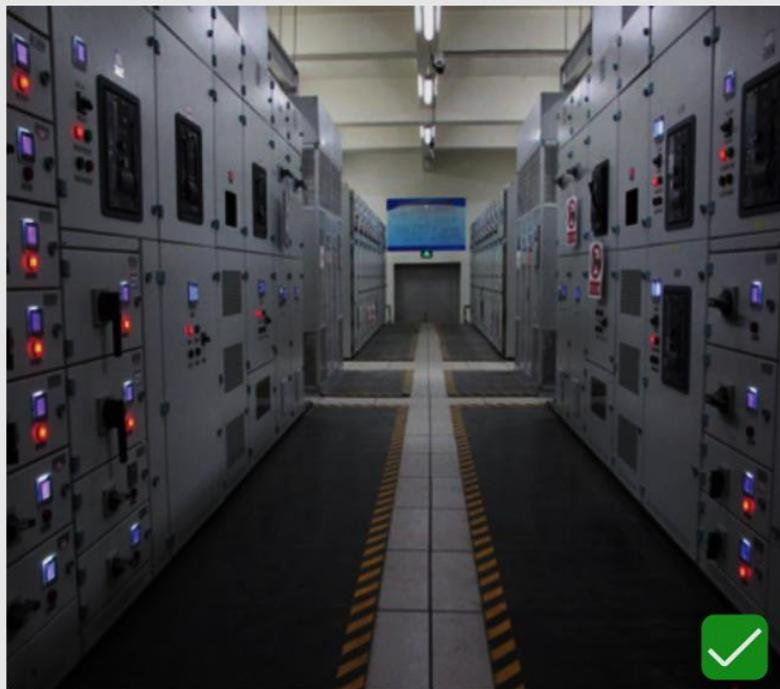
1. 配电柜排列整齐、稳固，柜体前后铺设绝缘胶垫，并设置标示线。
