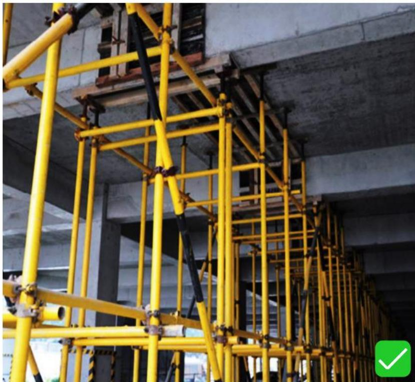
1. 后浇带采用独立支撑体系，与主体架体一起搭设。
