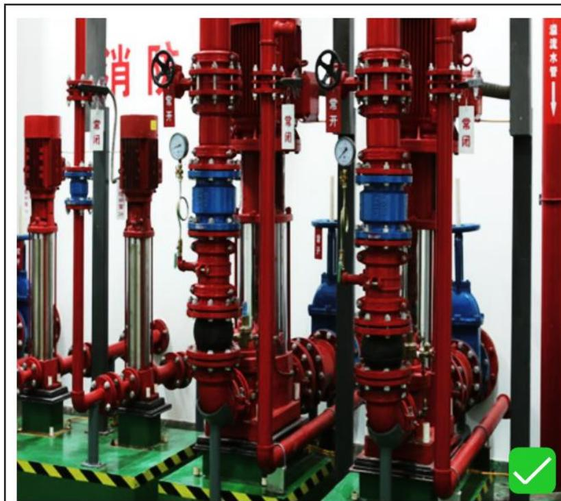
1. 软连接的法兰螺栓穿入方向朝外。
