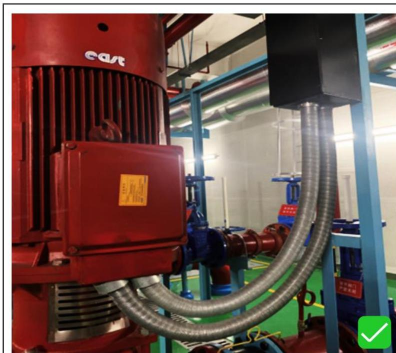
1. 电机接线采用可弯曲金属导管，敷设长度符合规范规定。
