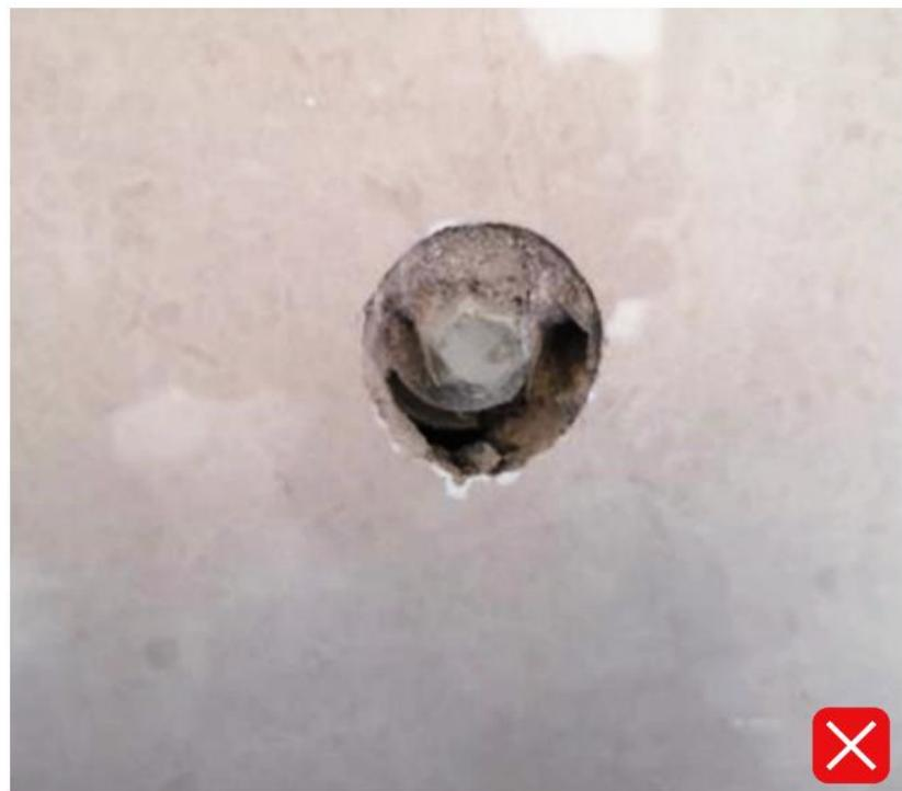
未采用专用开孔器或在饰面砖正面开孔，导致饰面砖孔口破损。
