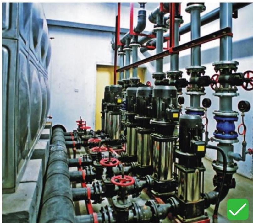
1. 水泵入口连接管道变径采用顶平偏心变径。
