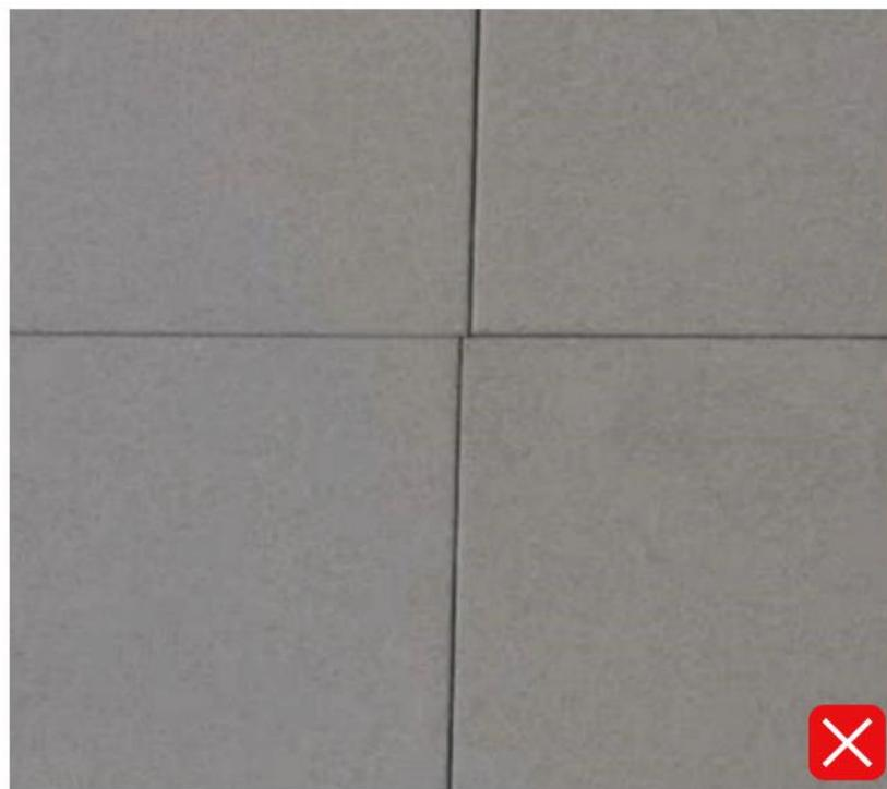
1. 罩面板裁剪不精确，扣板错缝。
