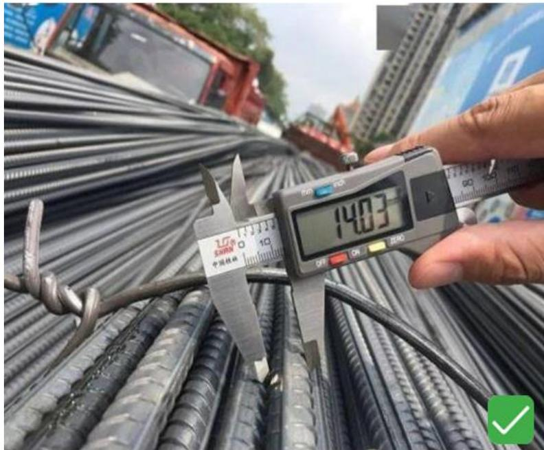
1. 钢筋进场后应进行验收，查看钢筋合格证，实测钢筋直径。
