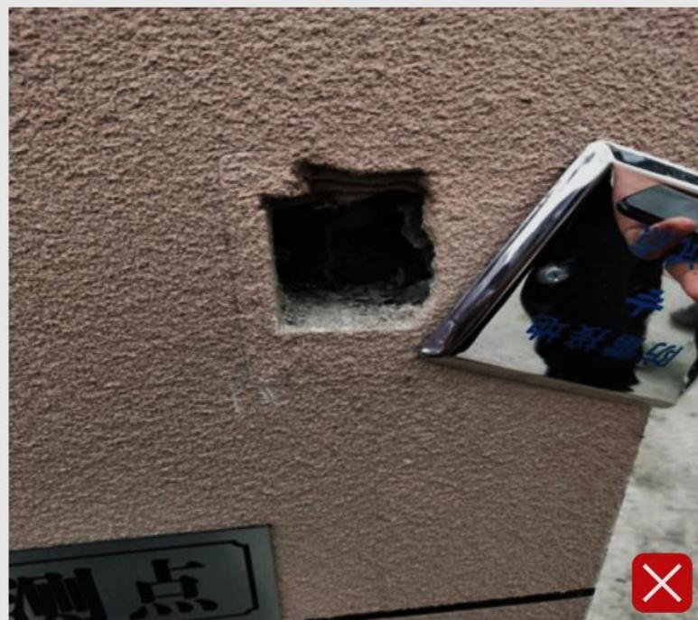
1. 接地测试盒高度不符合要求，无标识。
