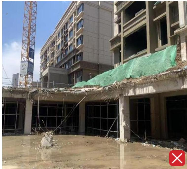
混凝土强度不合格，导致地下室局部坍塌、拆除。
