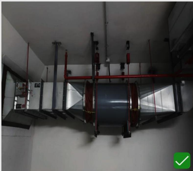
1. 柔性短管安装和风机同心，长度符合要求。
