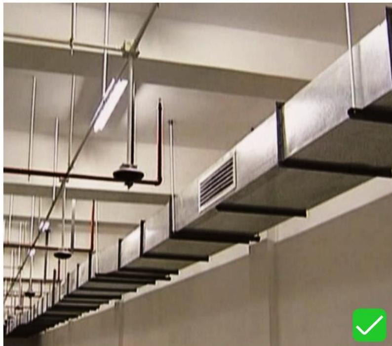
1. 金属风管接口连接严密、牢固。
