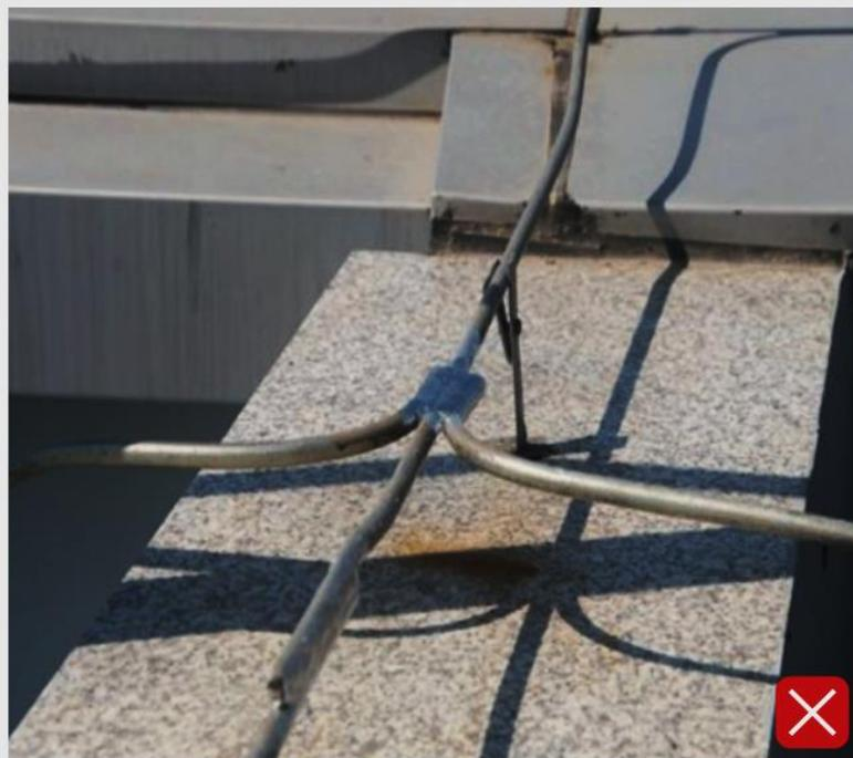
接闪带钢筋直径偏小，焊接部位生锈，搭接长度不足。
