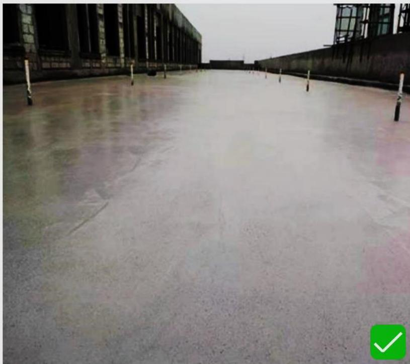
按方案有序浇筑屋面混凝土，采取有效措施控制找坡方向及坡度。
