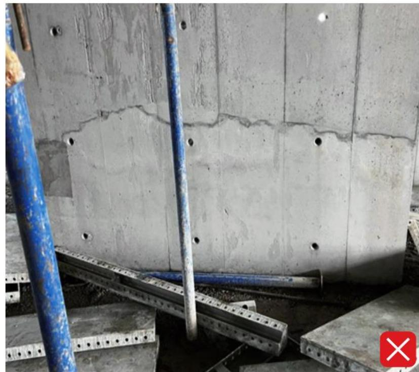
在高低强度混凝土交接处无拦截措施，梁板低强度混凝土流到墙柱内。
