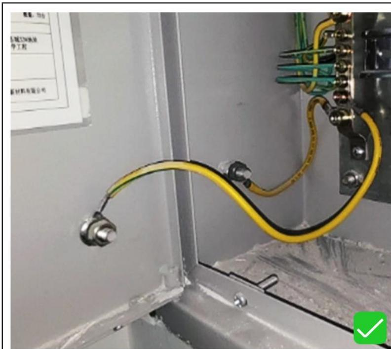
配电箱箱门单独与接地排连接，可靠接地。
