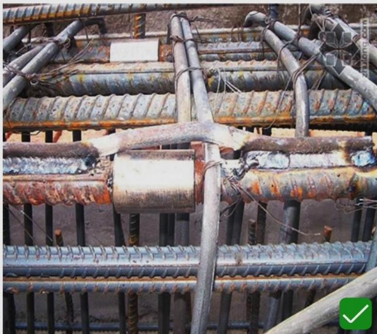
主体结构梁内跨接钢筋采用圆钢搭接，防雷钢筋焊缝饱满，连续通畅。
