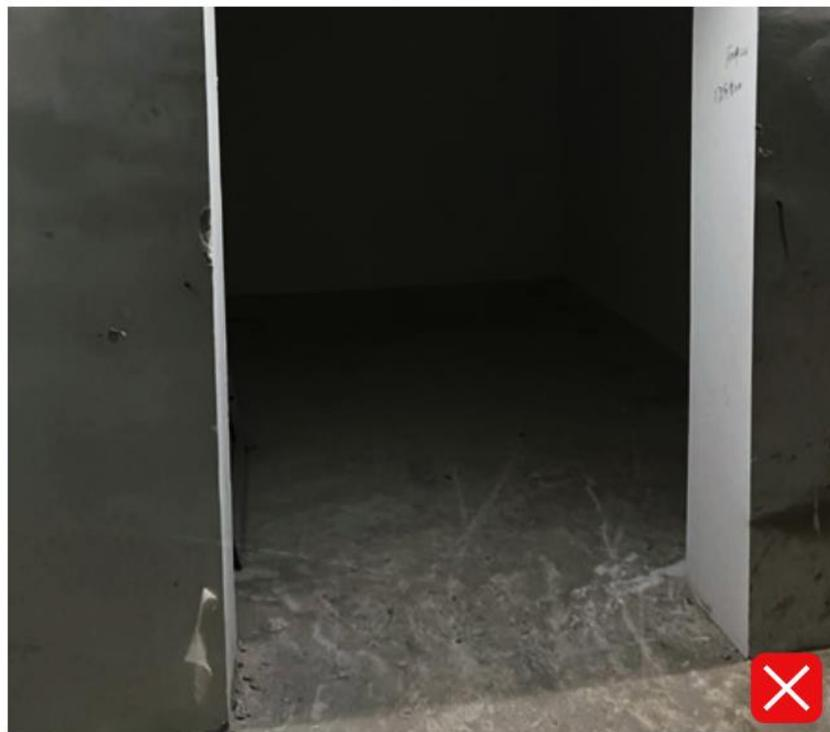
墙柱阳角无保护措施，造成墙柱破损缺失。
