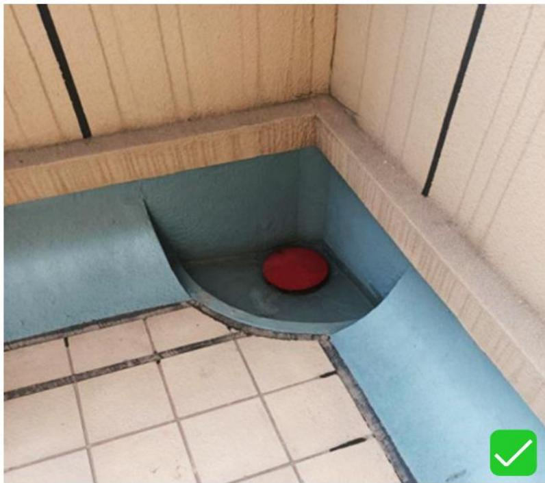
1. 雨水斗边缘与屋面面层交接处细部处理严密，无渗漏。
