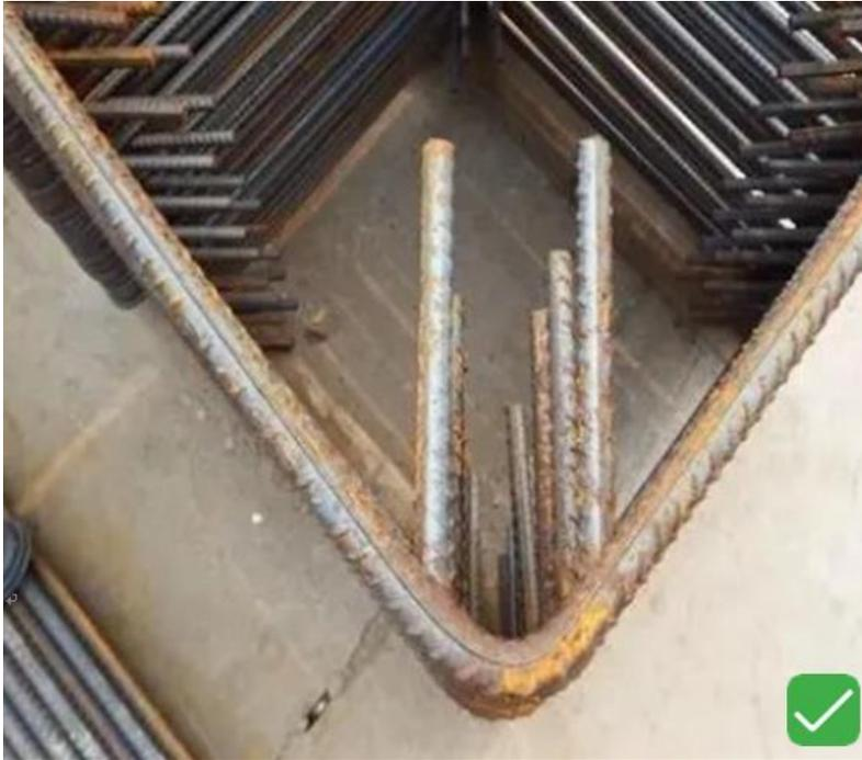
1. 箍筋弯钩的弯折角度不应小于  $135^\circ$  。
