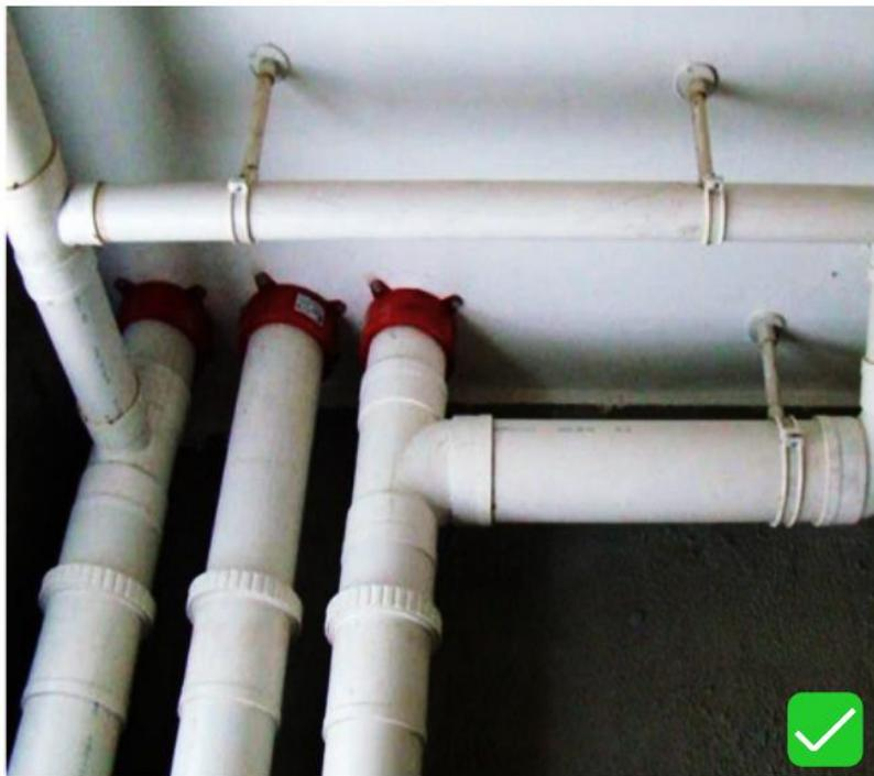
在排水立管穿楼板处设置阻火圈或阻火装置，阻火装置固定在楼板上。
