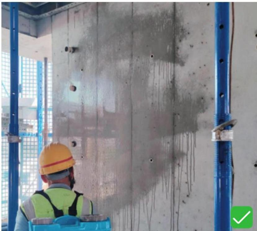
1. 混凝土浇筑后及时洒水或覆盖养护。
