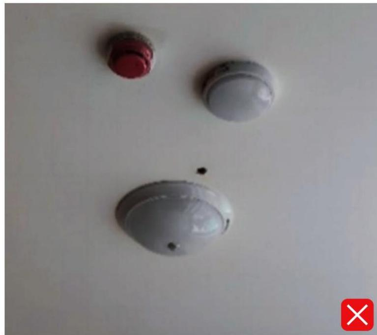
机电末端（风口、照明、探头、喷头、广播等）居中、成行成线布置，并安装牢固。
