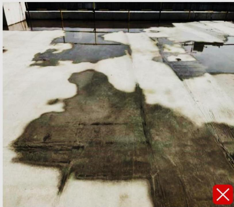
屋面混凝土面层坡度处理不到位，导致屋面积水。
