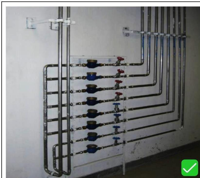
1. 水表、阀门安装位置正确，连接稳固，不渗水。
