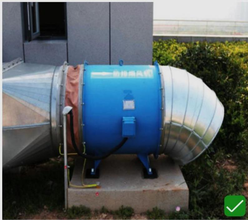
1. 屋面风机安装平整稳固，并设置减振装置，柔性短管长度150-250mm，松紧适度。
