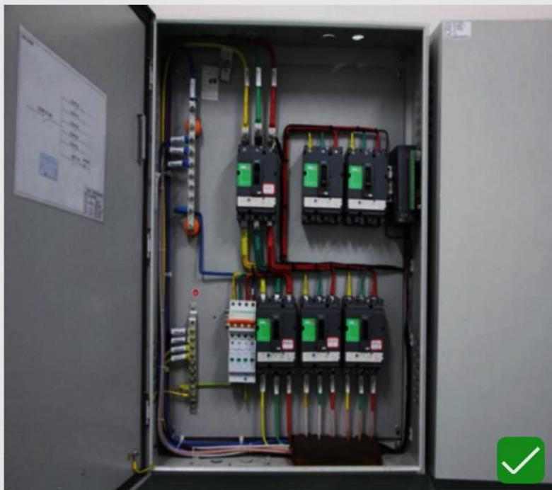
1. 箱内线缆绑扎固定牢固，导线留有一定的余量。
