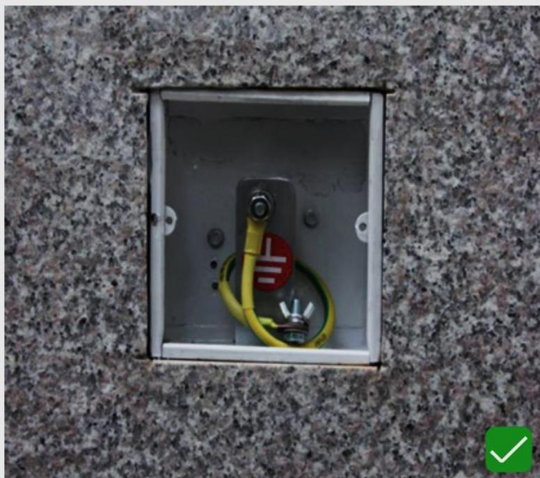
1. 建筑物外墙防雷接地测试盒安装稳固，高度符合规范要求，标识清晰，方便测试。
