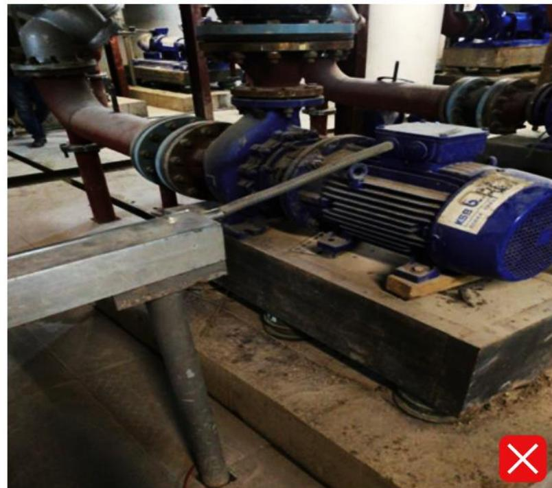
1. 水泵减震器嵌入设备基础找平层。
