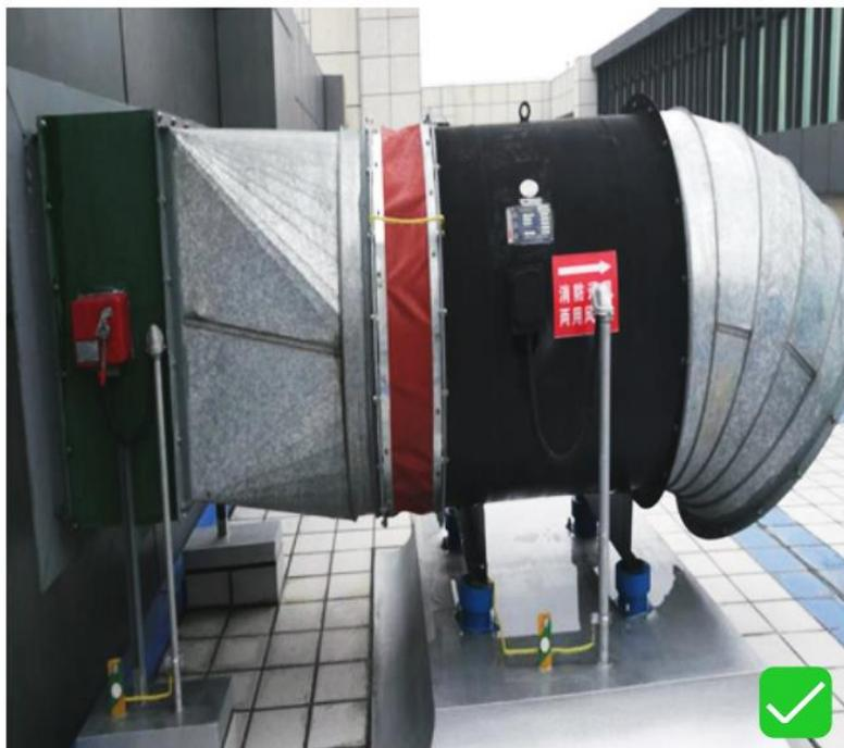
屋面风机等设备外壳、电气导管按规范要求可靠接地。
