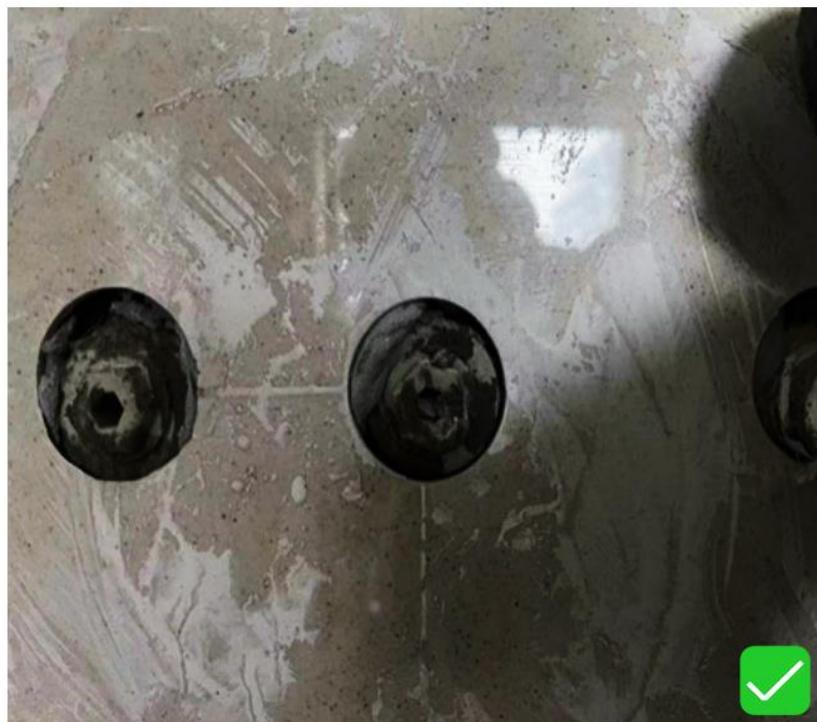
采用专用开孔器在饰面砖背面开孔，保证孔口光滑美观，孔径适宜。
