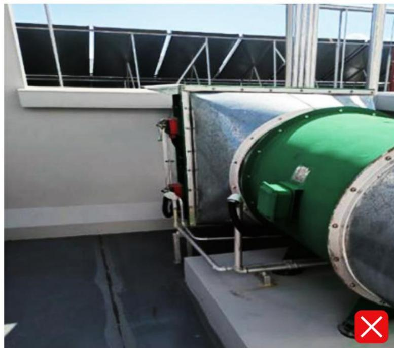
屋面设备与电气导管未按规定要求可靠接地。
