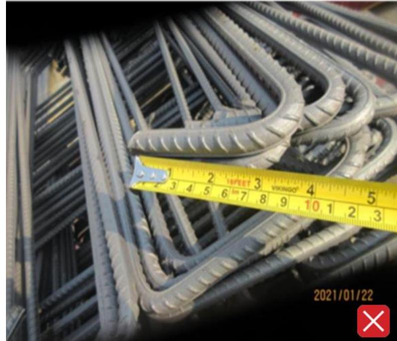
箍筋弯折后平直段长度不满足10d要求。
