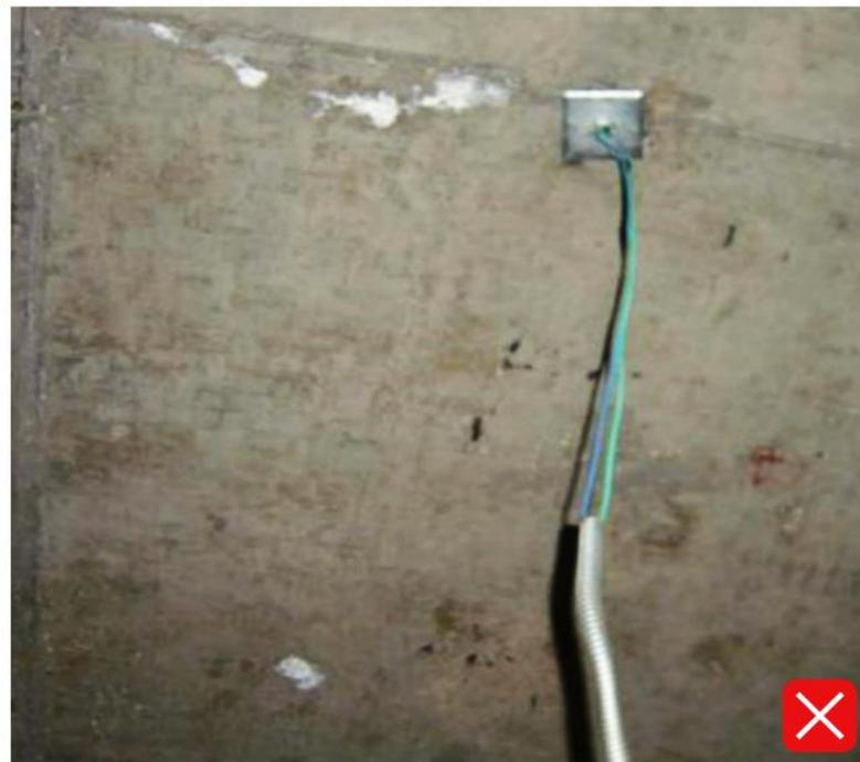
1. 软管接头脱落，导线外漏。
