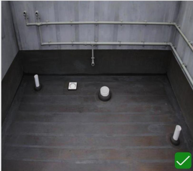
1. 冷热水管道安装遵循“上热下冷，左热右冷”原则。
