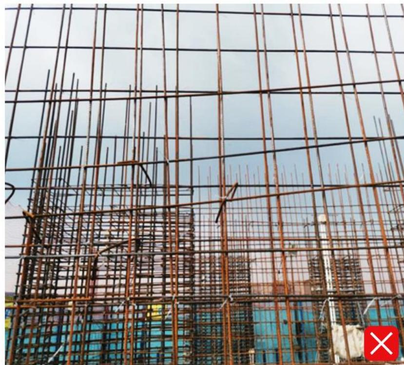
1. 墙柱钢筋无定位措施。
