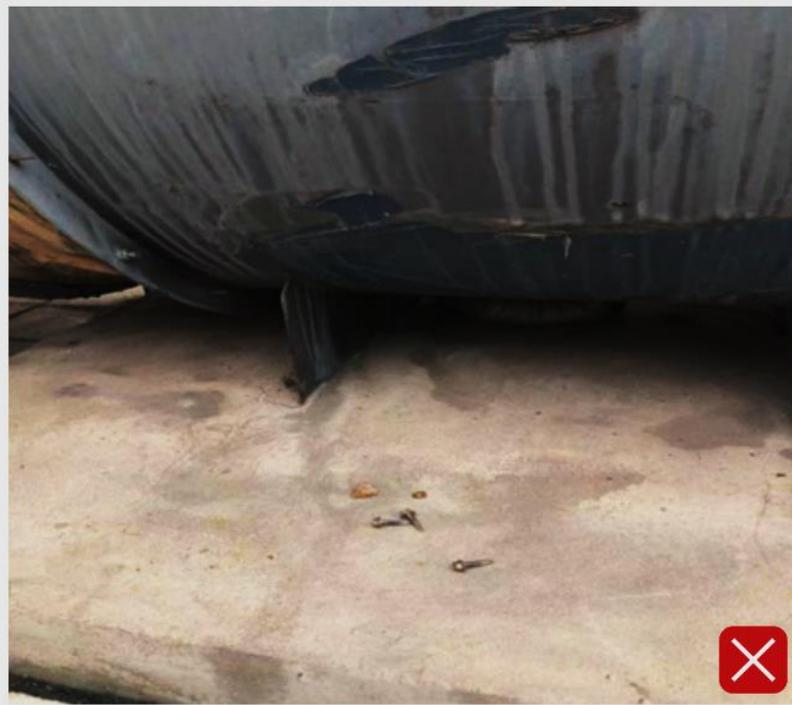
风机减震垫埋入基座水泥砂浆面层中失效。
