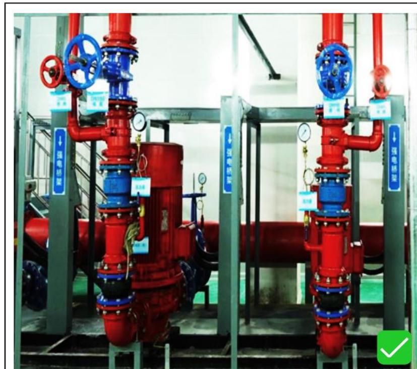
1. 管道阀门、法兰的型号符合设计及规范要求。
