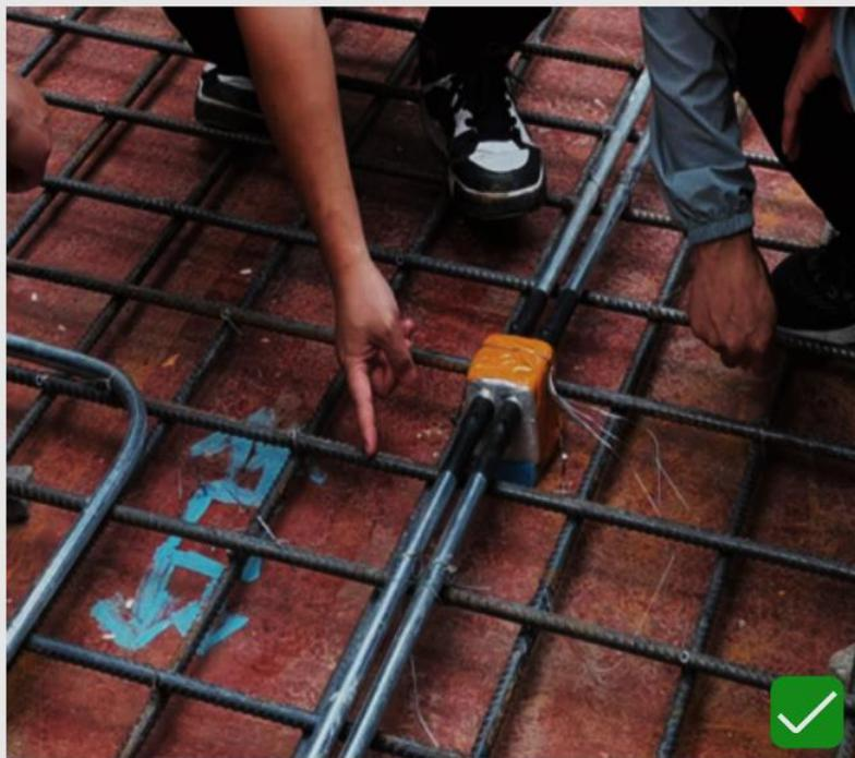
1. 金属线管预埋定位精准，安装稳固，连接紧密。
