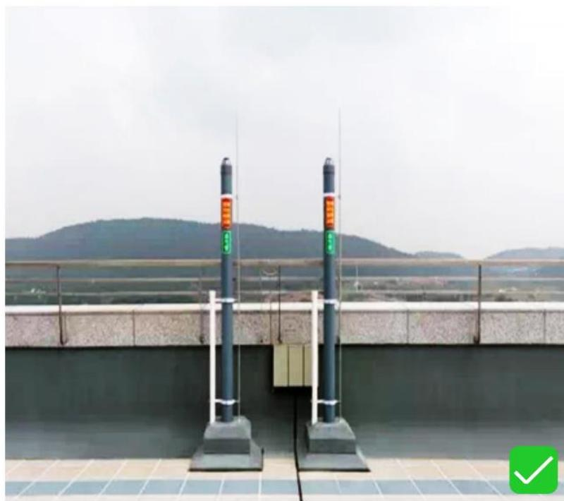
1. 排水通气管高度正确，设置有效防晃、防雷装置。
