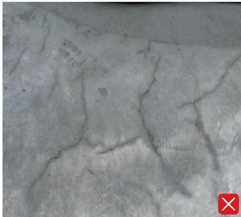
混凝土养护不及时、混凝土收面过晚导致面层开裂。
