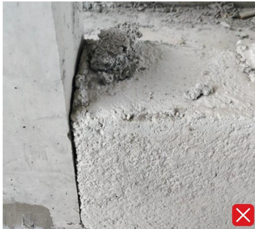
1. 接触面结构未凿毛, 二次浇筑混凝土存在明显缝隙。
