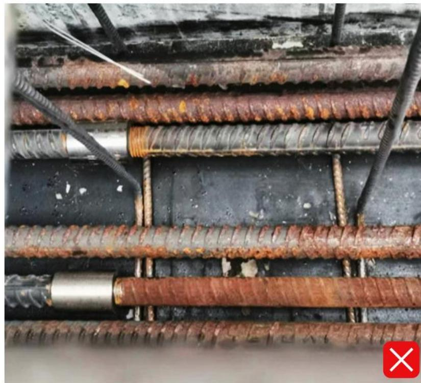
1. 梁底纵向钢筋未绑扎，主筋间距布置不正确，钢筋机械连接接头未拧紧。
