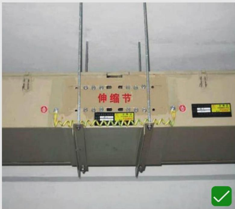
1. 电缆桥架跨越建筑物变形缝处设置变形补偿装置。
