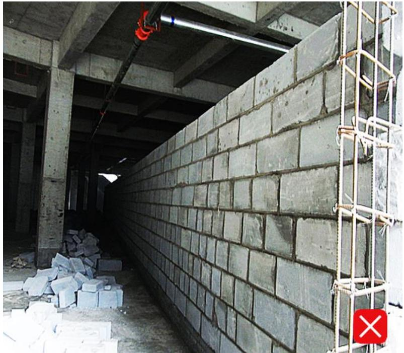
墙长大于5m未设置构造柱，墙高超过4m未设置圈梁。
