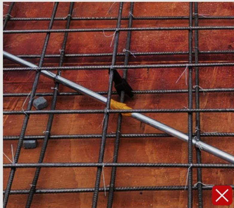
金属线管接头处使用胶带密封可靠性差。
