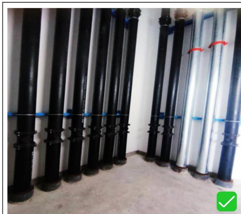
竖井内，管道与套管间隙采用柔性防火材料封堵严密。
