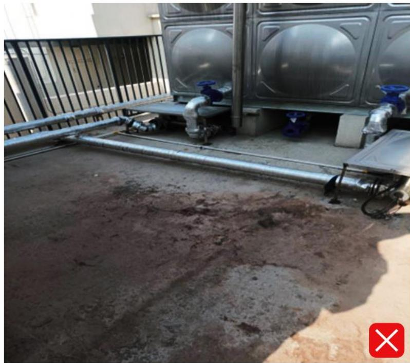
溢流管、排空管端头未设置不锈钢防虫网。
