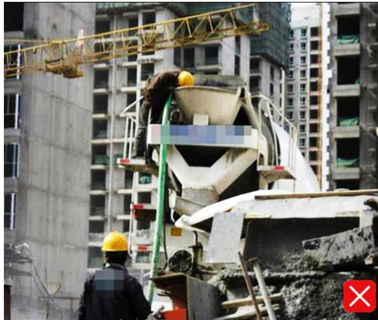
混凝土运输、输送过程中加水。
